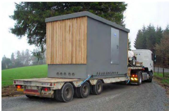
Figure 421 : Arrivée d'un poste de livraison sur un site éolien (Source : VALECO)
