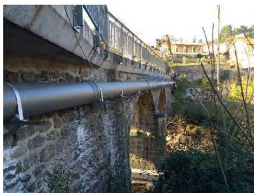
Figure 410 : Exemple d'encorbellement (source : rampa-tp.com)
