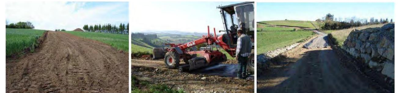
Figure 416 : Tracé de la piste ; Pose du géotextile ; Mise en place du gravier (Source : VALECO)
