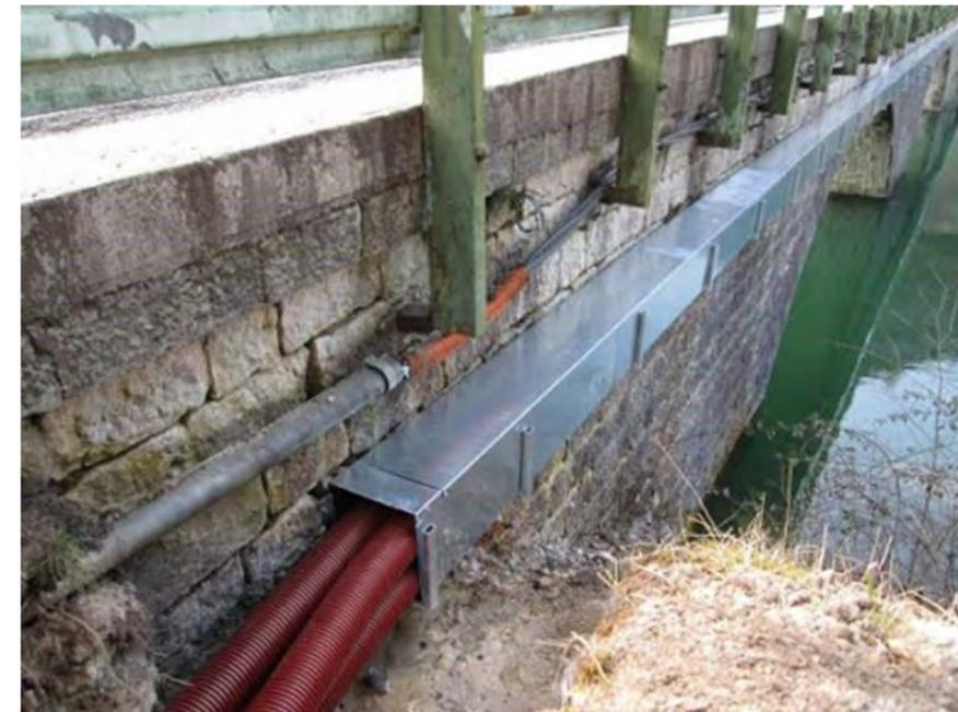
Figure 426 : Passage de câbles en encorbellement (Source : VALECO)
