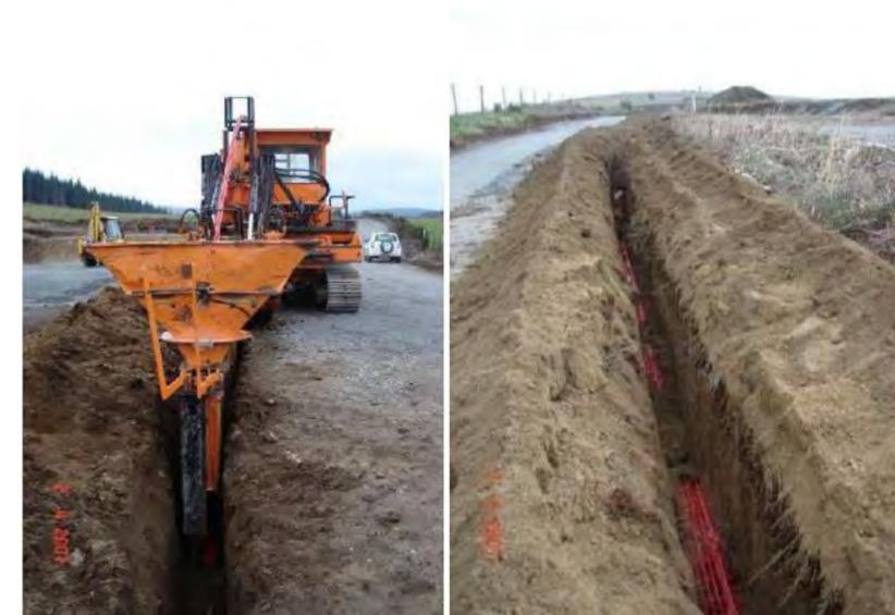
Figure 419 : Réalisation de la tranchée et de la pose du câble simultanément (Source : VALECO)
